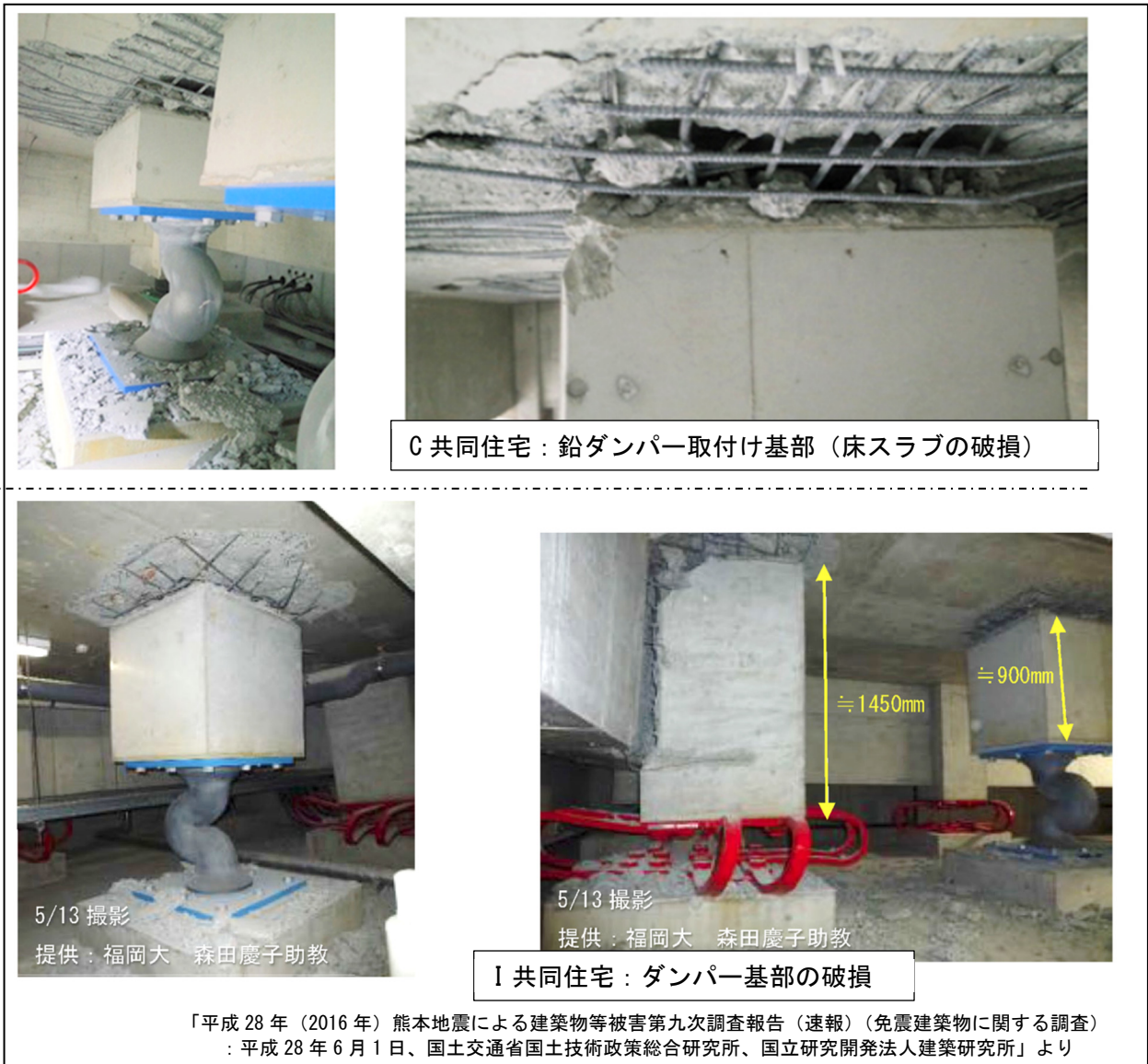
[図 3-16 熊本地震でのダンパー基部の損傷 12) ]
