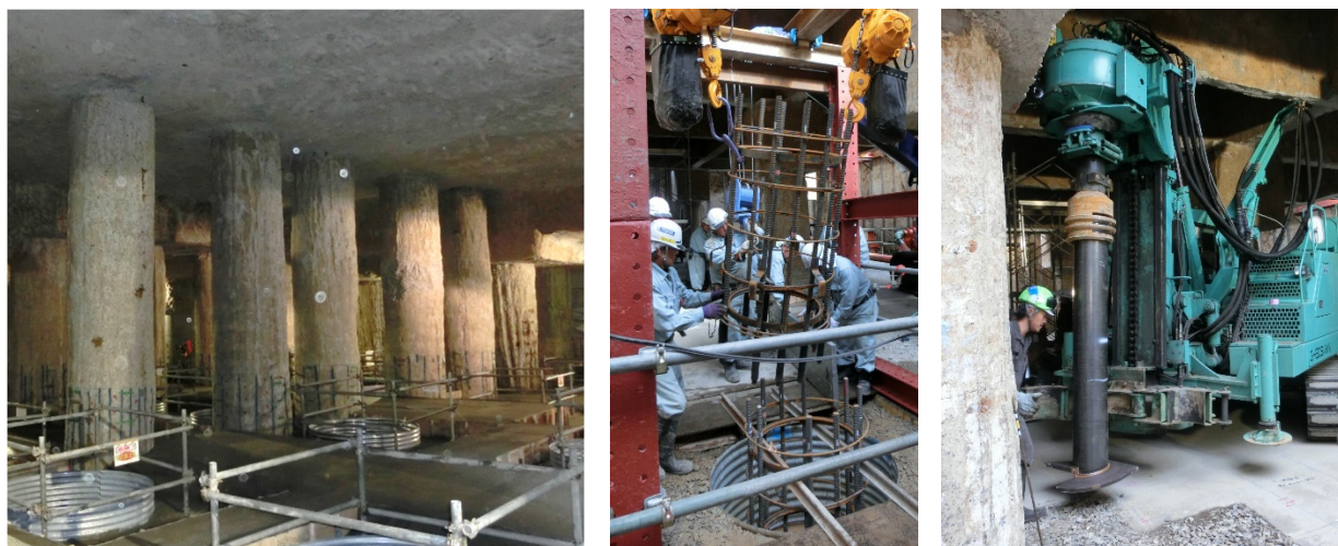
＜既存杭（掘削後、新設杭施工前）＞ ＜杭配筋の分割施工＞ ＜鋼管杭の施工＞
