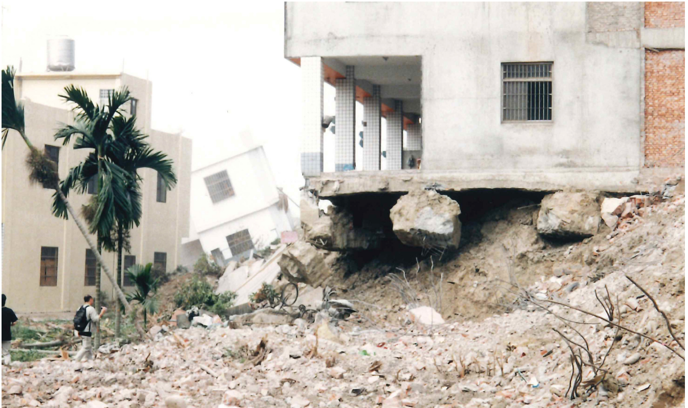
[図 6-1 1999年台湾集集大地震での活断層直上の建物被害状況(台湾台中豊原) 撮影:中川理]
