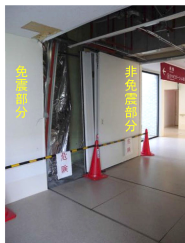
エキスパンションカバー周囲の変状 破損したエキスパンションカバー (撤去済み)
