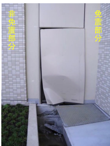
エキスパンションカバー周囲の変状 破損したエキスパンションカバー (撤去済み)
