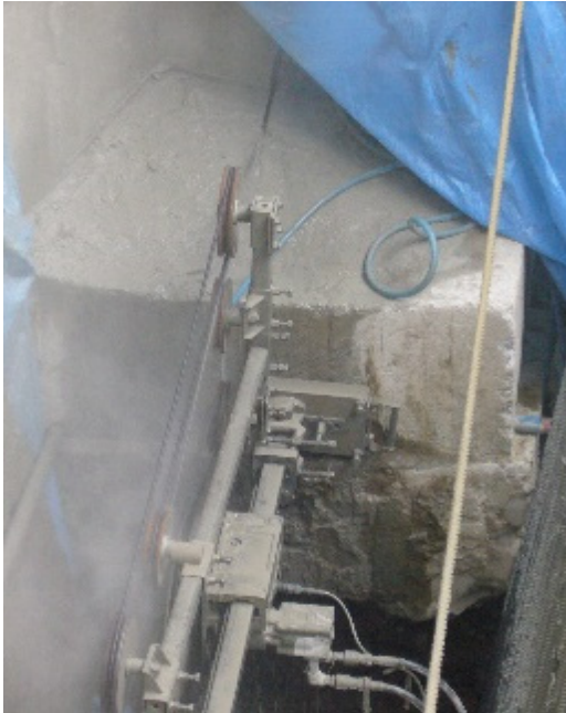
(フーチング切断) [図 4-9 ワイヤーソー施工例]
